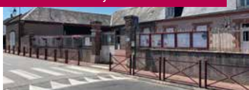
Rénovation des grilles et du portail de la mairie 18 300 € *
