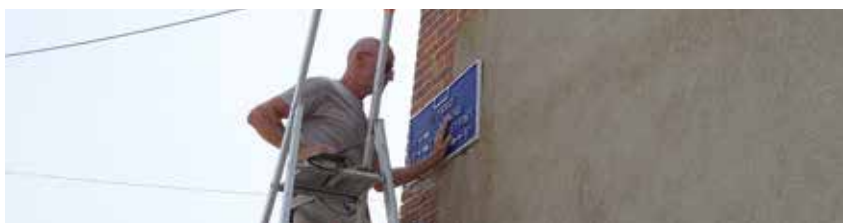
Après : Pascal refixe la plaque, l'opération rénovation est terminée.
