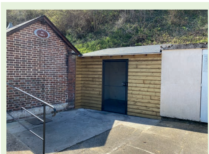
Suite au sinistre, un nouveau local poubelle a été réalisé place Jean-Moulin. Il est fermé et réservé aux utilisateurs des salles Isambert et Jean-Moulin.
