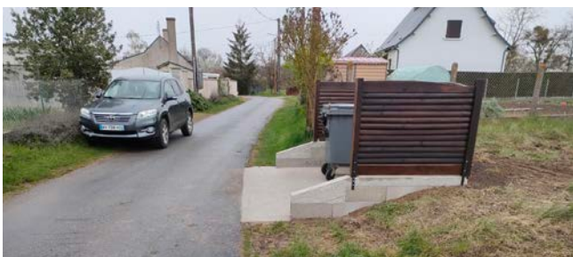
Le local poubelle de Vilquier a été aménagé.
