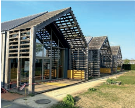
Terrasse et chemins d'accès aux classes (enrobé)
