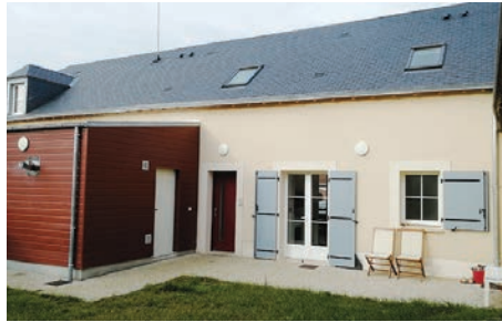
Deux logements locatifs ont été réalisés.
